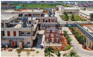
Unit-4, Atchutapuram 1,995 KL A C
